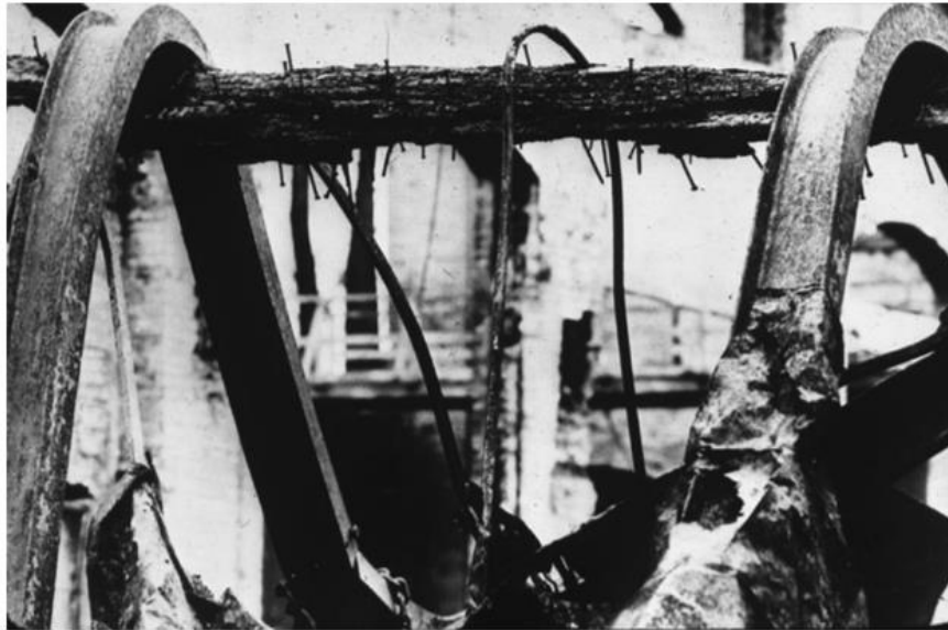
Slika 3.15. Drveni i čelični nosači nakon požara [4]
