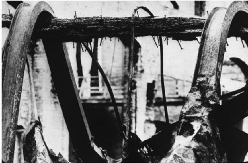
**Slika 3.15. Drveni i čelični nosači nakon požara [4]**
