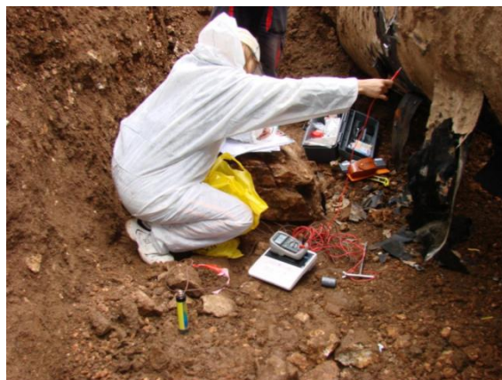
Slika 15. Izravno mjerenje potencijala cjevovod – tlo u iskopu [19]
