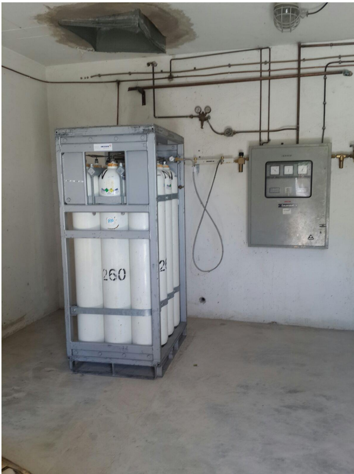
Slika 24. Razvodni sustav za dušični oksidul
