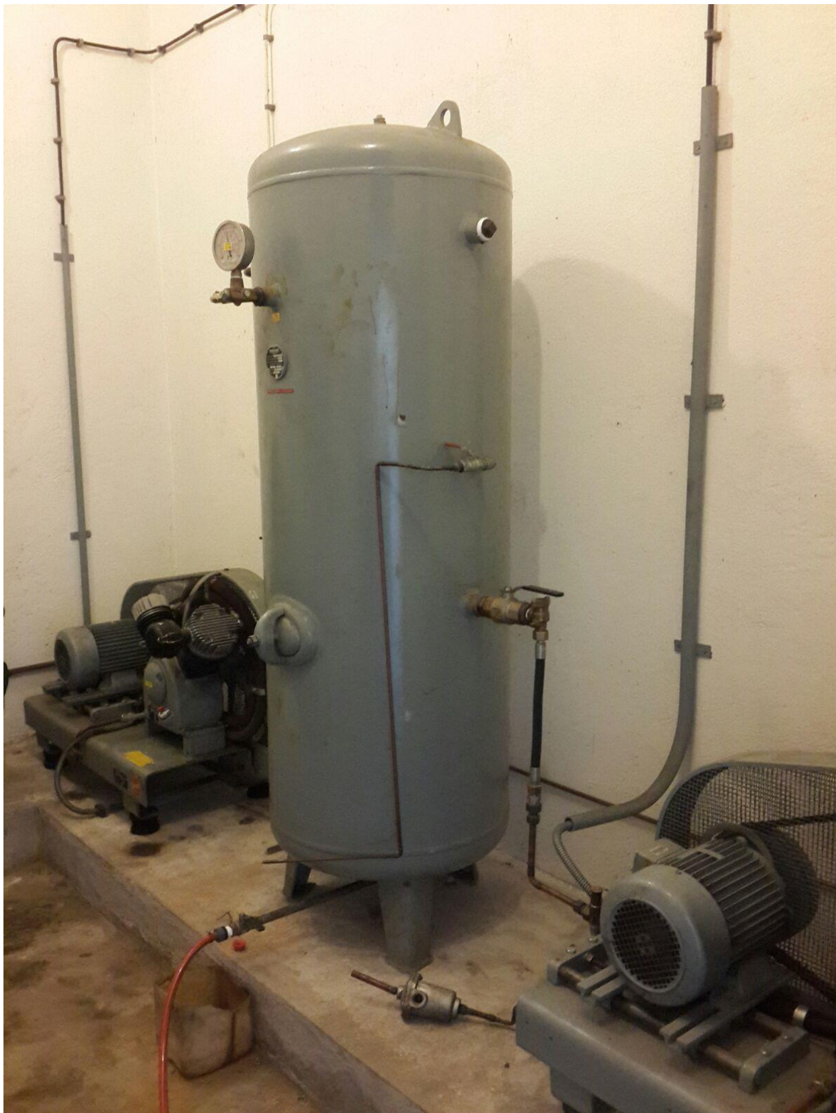
Slika 23. Spremnik za komprimirani zrak
