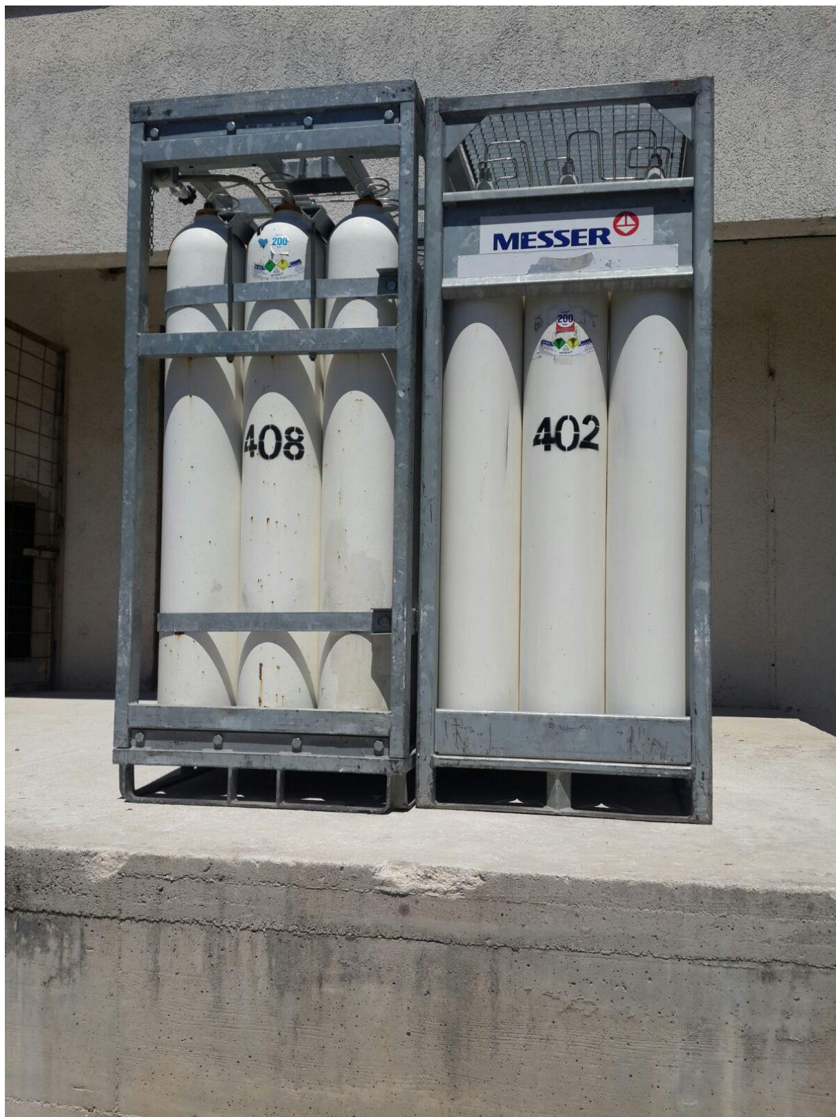
Slika 26. Spremište baterija dušičnog oksidula
