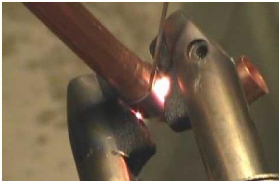
Slika 8: Otporno lemljenje bakrenih cijevi [12]
