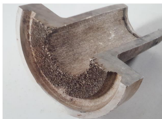
Korozija u procjepu
