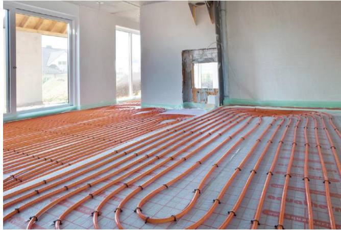
Slika 1.11. Podne cijevne petlje
