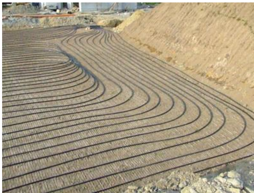
Slika 4.2. Primjer polaganja kolektorskog polja
