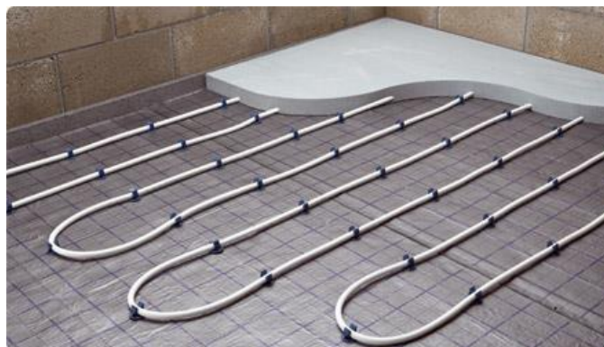
Slika 3.3. Primjer serpentinke petlje podnog grijanja
