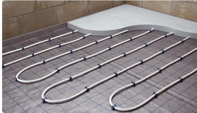
Slika 3.3. Primjer serpentinke petlje podnog grijanja
