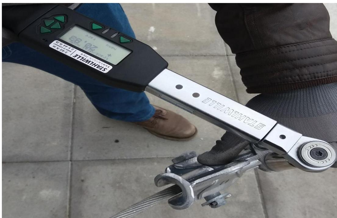
Slika 22. Pritezanje vijaka stezaljke s momentom 20 Nm
