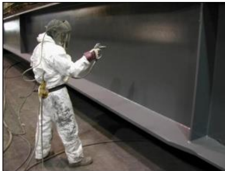
Slika 10: Nanošenje premaza bezračnim prskanjem [13]
