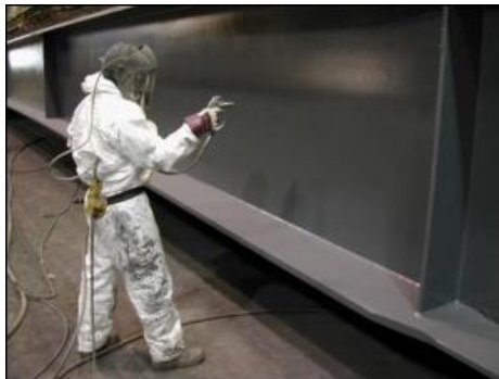
Slika 10: Nanošenje premaza bezračnim prskanjem [13]
