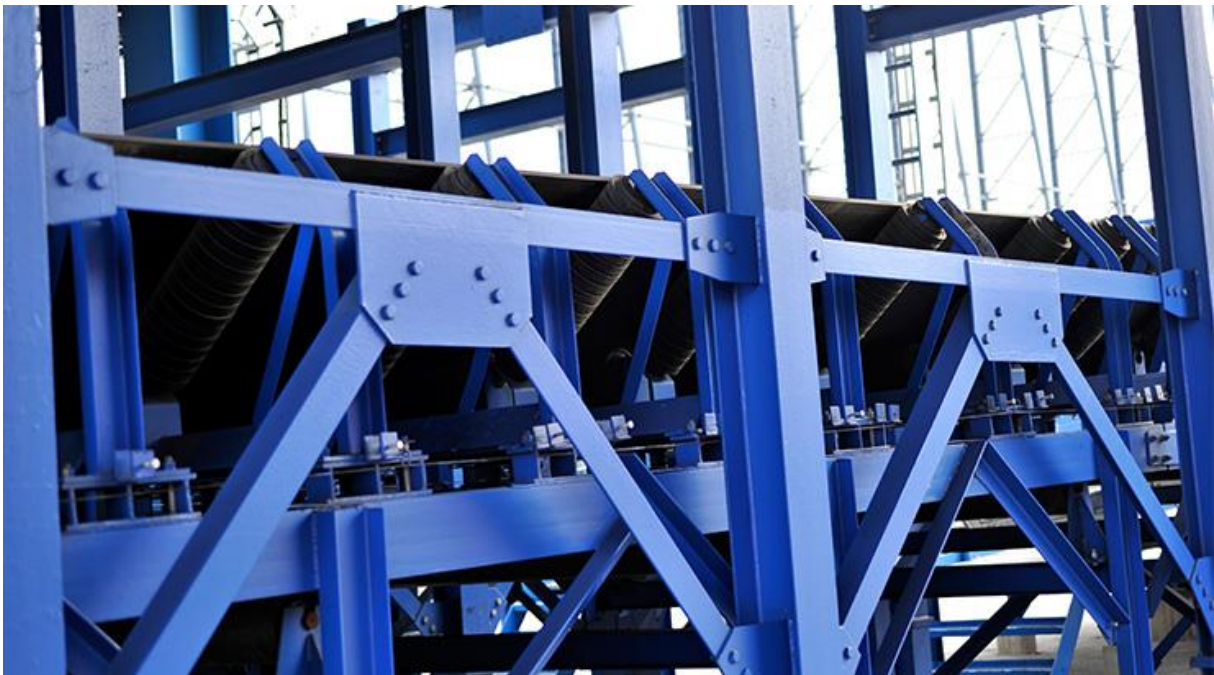
Slika 13: Primjer primjene vodorazrjedivih premaza [22]
