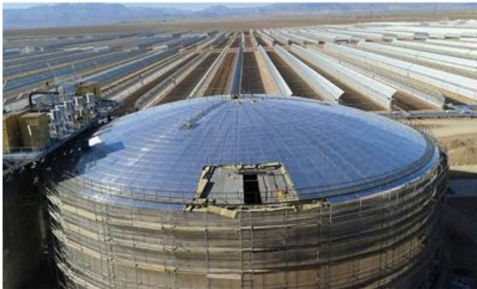
Slika 14. Prikaz gradnje toplinskog spremnika "Noor 1" postrojenja od 160 MW [30]
