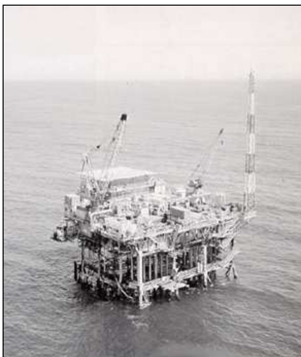
Slika 30. Platforma zaštićena vodorazrijedivim premazom [14]
