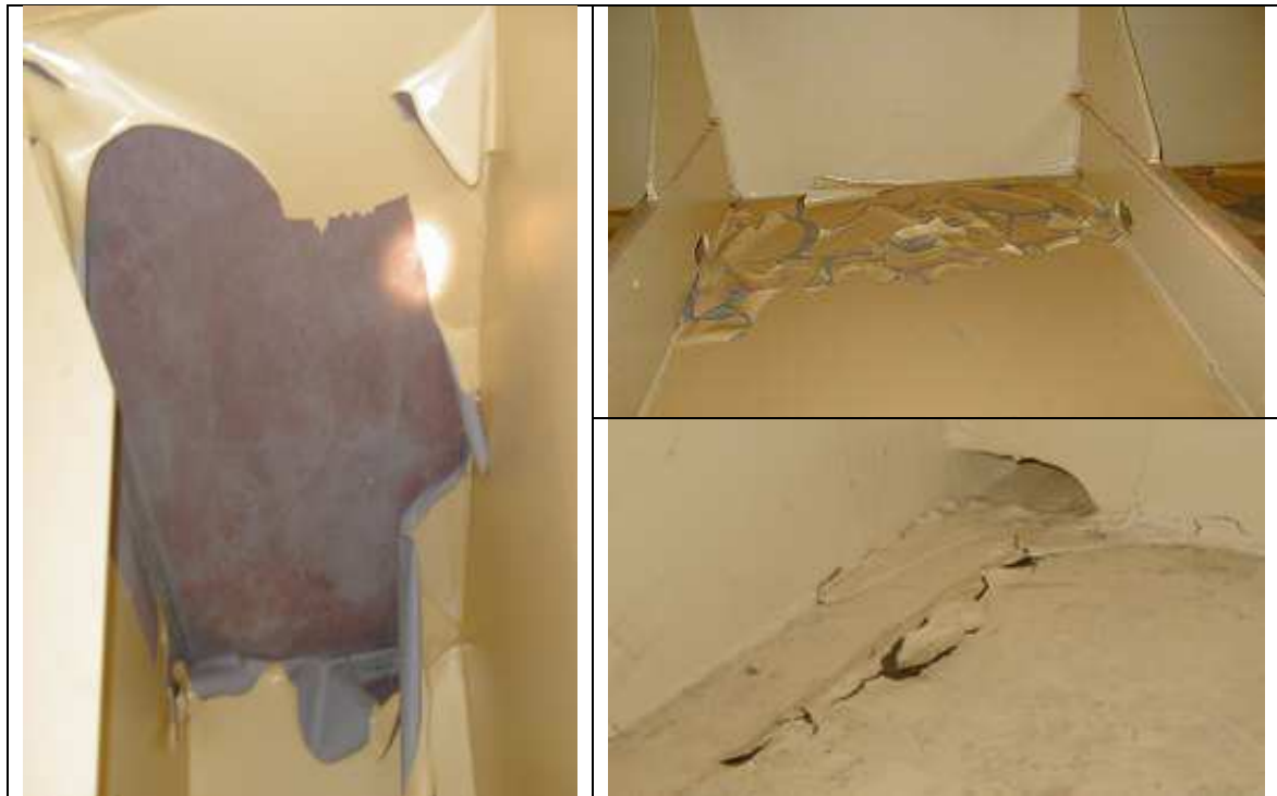
Slika 20. Greške uslijed slabe adhezije [6]
