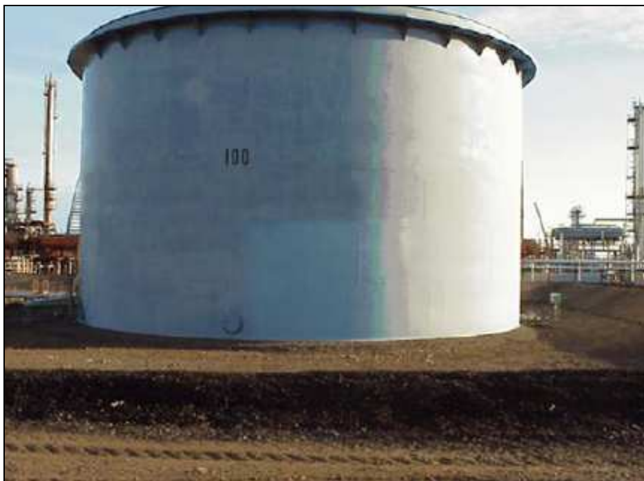
Slika 32. Spremnik za naftu zaštićen sistemom boja na bazi otapala i hibridnim sistemom [14]
