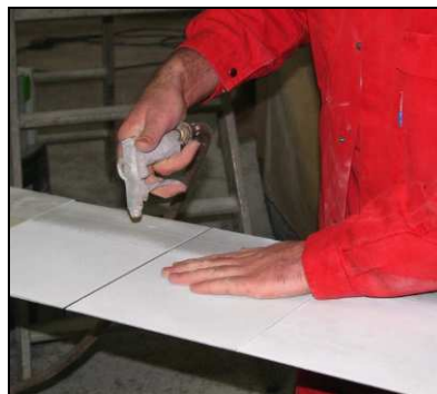
Slika 41. Ispuhivanje prašine [17]
