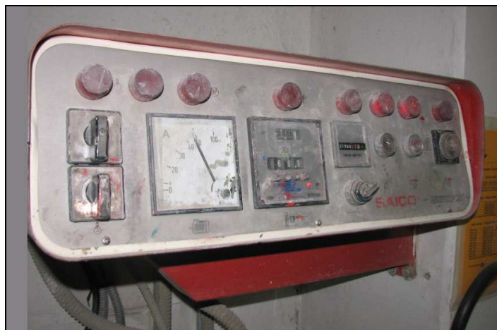
Slika 37. Uređaj za regulaciju temperature i ventilacije [17]
