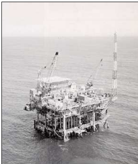
Slika 30. Platforma zaštićena vodorazrijedivim premazom [14]
