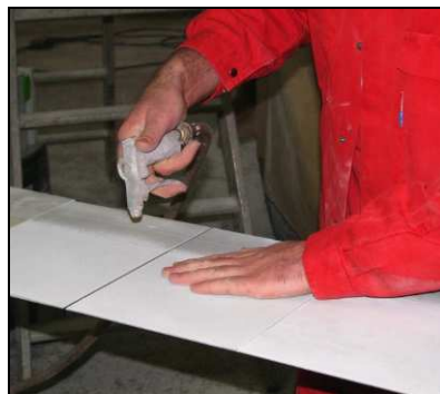
Slika 41. Ispuhivanje prašine [17]
