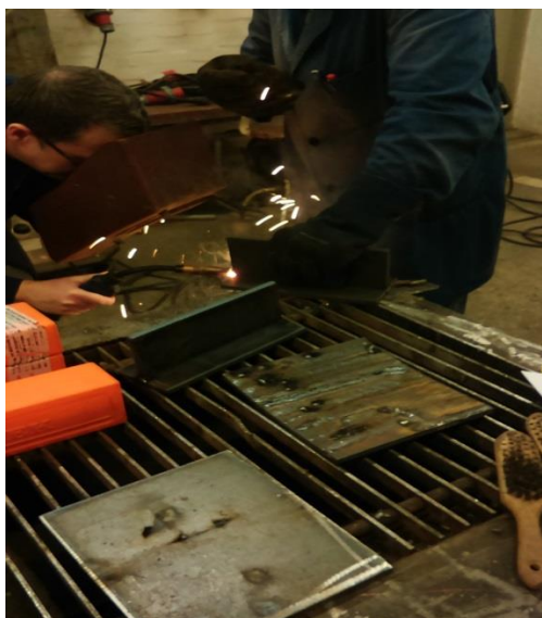
Slika 22. Zavarivanje pripoja MAG postupkom
