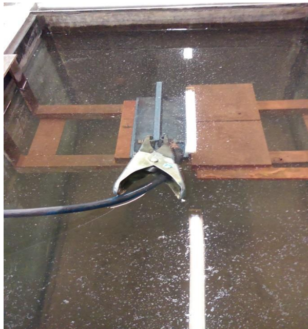
Slika 24. Kutni spoj pripremljen za zavarivanje
