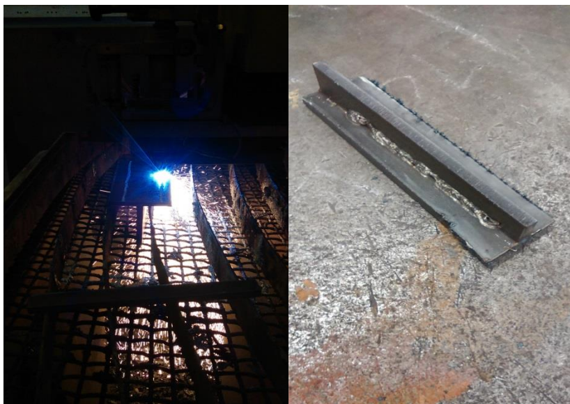
Slika 29. Rezanje viška dijelova ploča kutnog spoja
