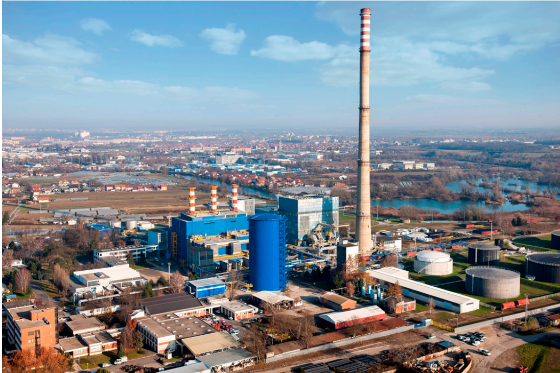
Slika 2.1: Pogled na postrojenje TE-TO Zagreb [8]
