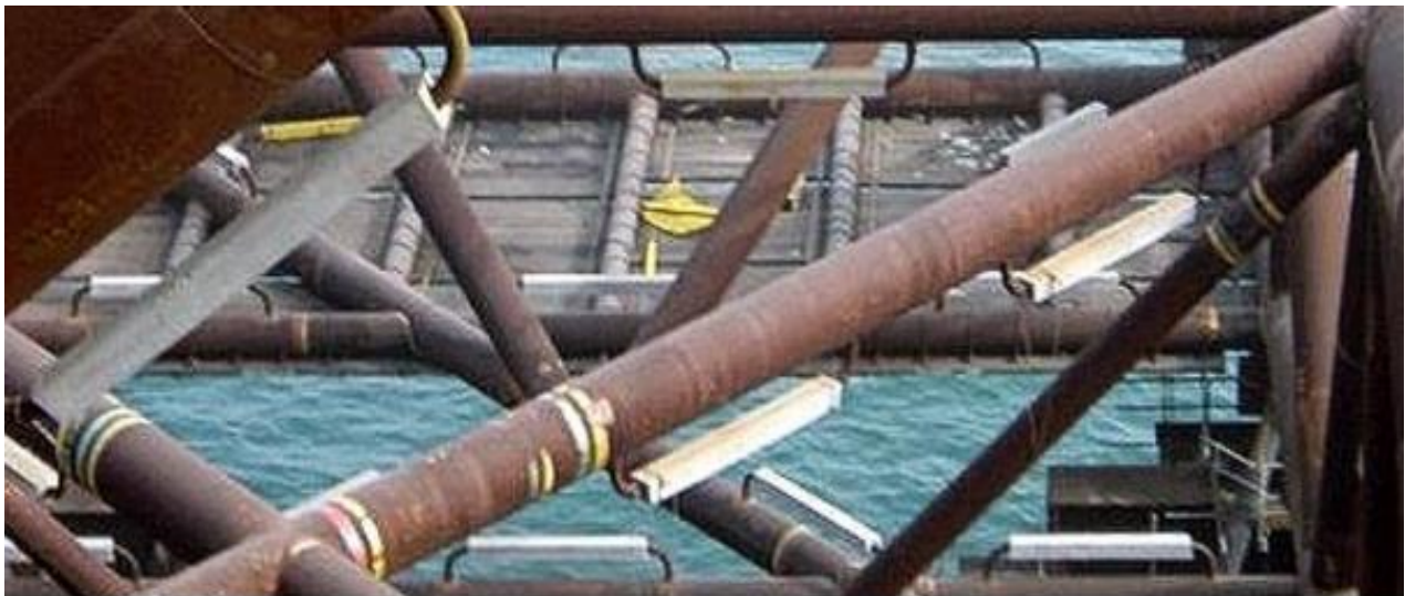
Slika 12. Prikaz katodne zaštite žrtvovanom anodom [15]
