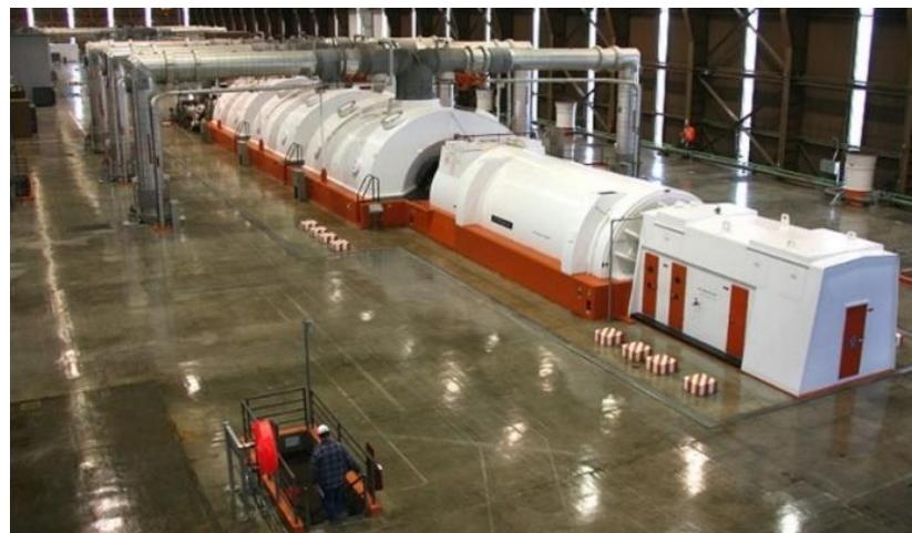
Slika 7. Sklop turbina - generator
