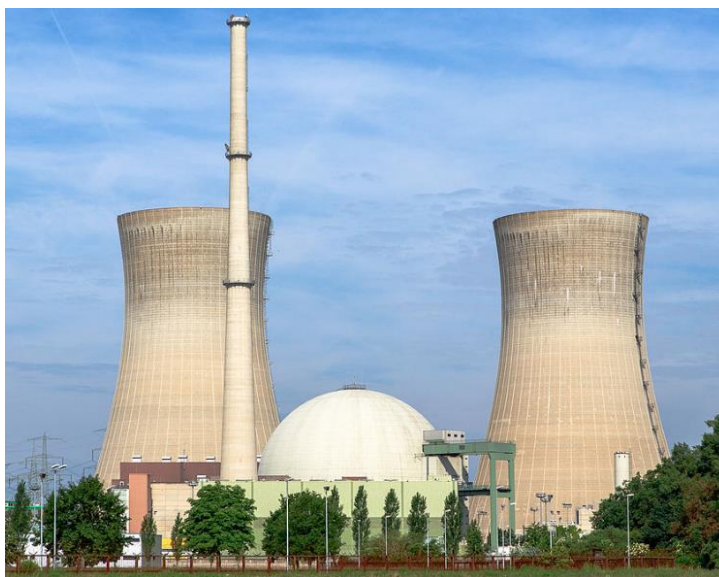
Slika 1. Nuklearna elektrana s rashladnim tornjevima i reaktorskom zgradom
