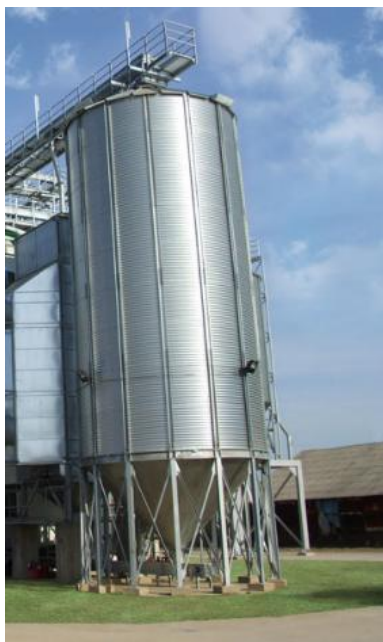
Slika 18. Silos s lijevkom
