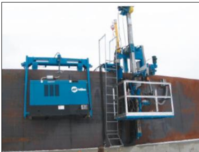
Slika 10. Oprema za EPZ na spremniku s pokretnim izvorom napajanja [7]
