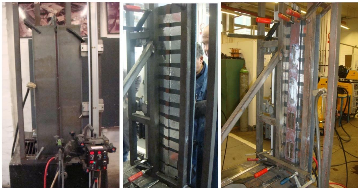
Slika 25. Priprema za zavarivanje
