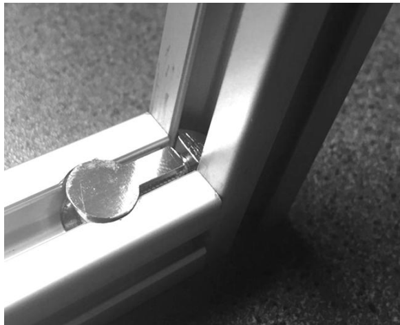
Slika 67. Spoj dva ekstrudirana aluminijska profila
