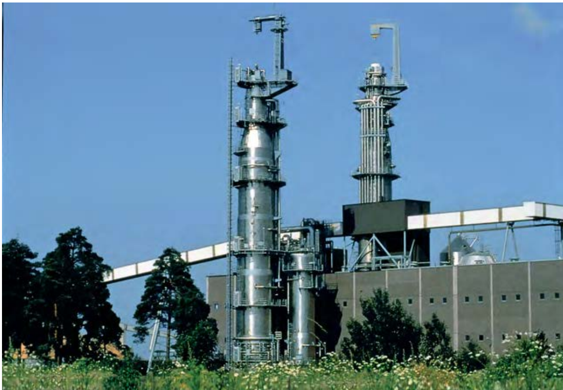
Slika 10. Postrojenje kontinuiranog fermentatora sulfata i impregnacijskog tornja u mlinu Södra Cell Mönsterås u Švedskoj [7]
