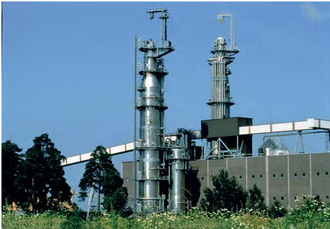
Slika 10. Postrojenje kontinuiranog fermentatora sulfata i impregnacijskog tornja u mlinu Södra Cell Mönsterås u Švedskoj [7]
