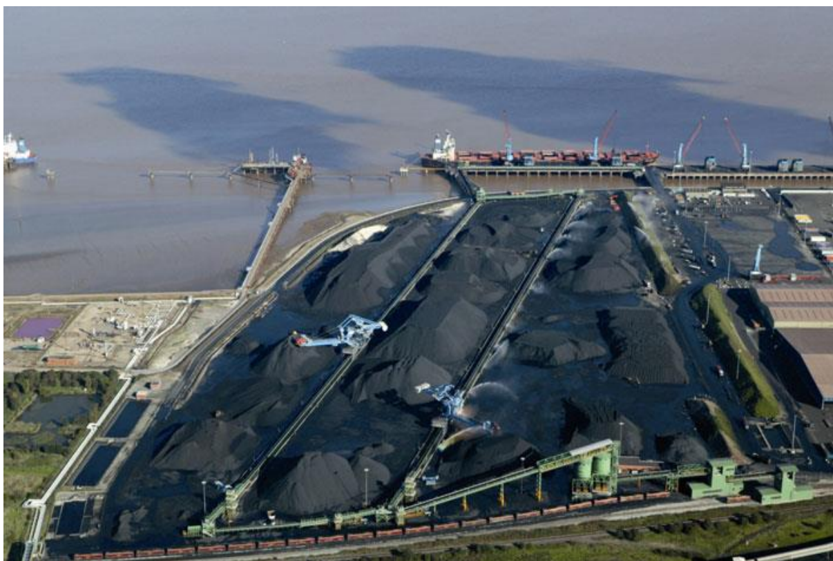
Slika 1. Odlagalište ugljena sa dva Stacker-Reclaimer-a
