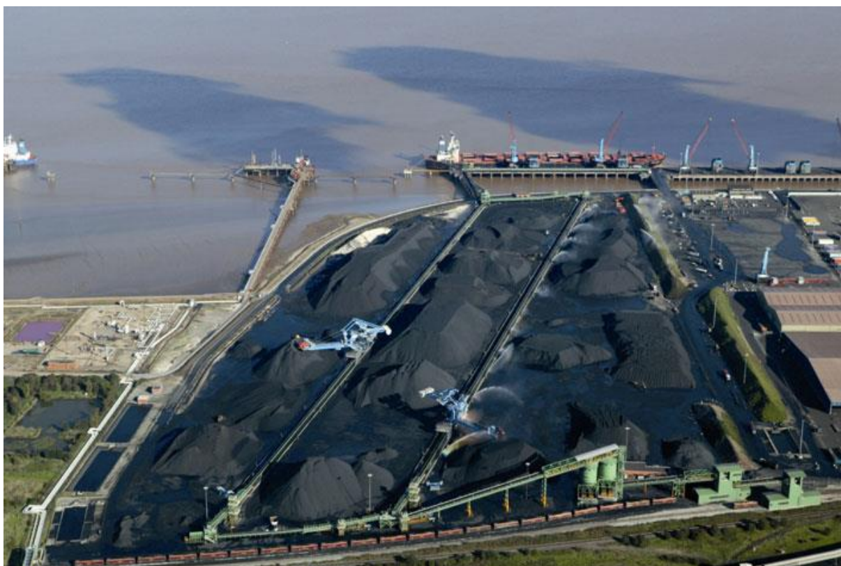
Slika 1. Odlagalište ugljena sa dva Stacker-Reclaimer-a
