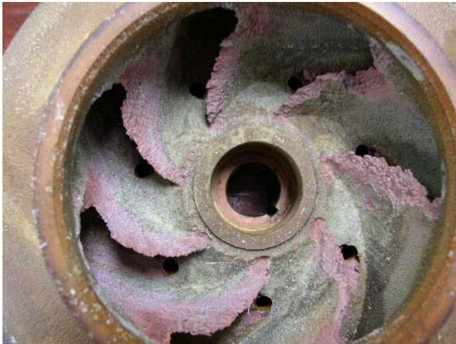
Slika 9. Erozijska korozija na lopaticama [13]
