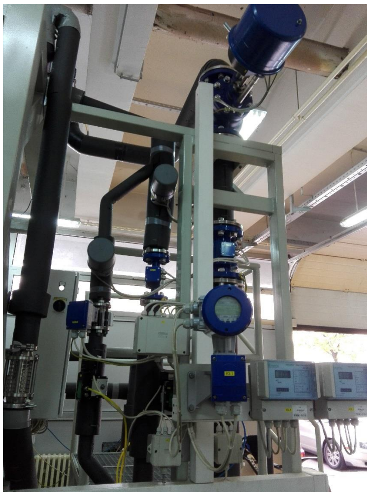
Slika 25. Magnetno induktivna mjerila protoka (MID)
