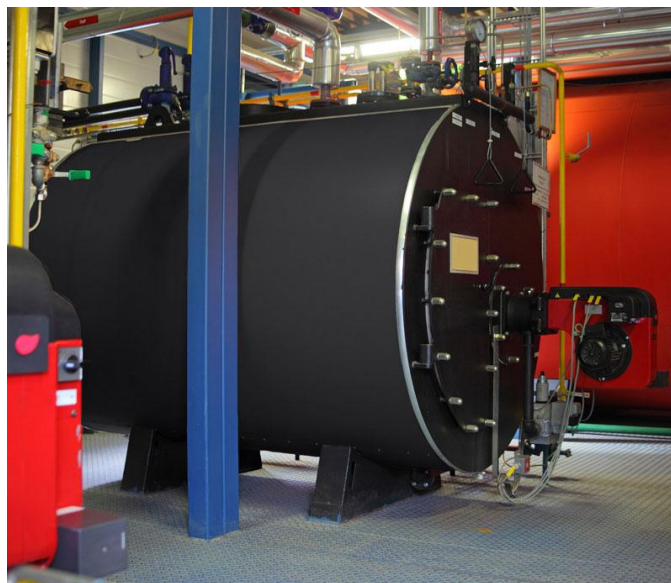
Slika 15. Spremnici za vodu premazani izvana alkidnim premazima [19]
