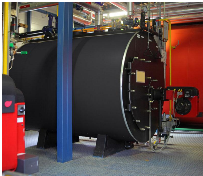
Slika 15. Spremnici za vodu premazani izvana alkidnim premazima [19]
