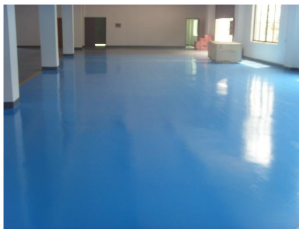
Slika 16. Epoksidne prevlake industrijskih podova [19]
