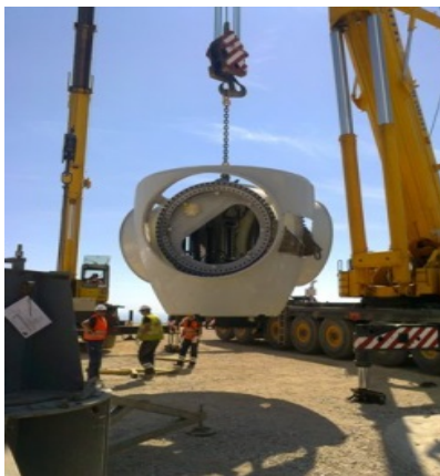
Slika 3.2 Gondola vjetroagregata [5]
