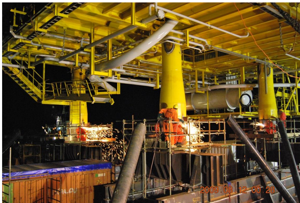
Slika 33. Uklanjanje morskog veza nadgrađa [15]
