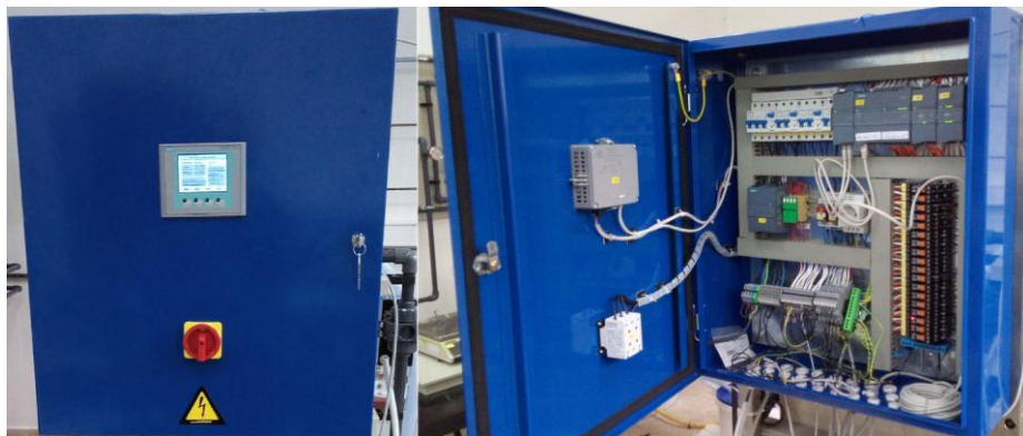
Slika 18. PLC Siemens Simatic
