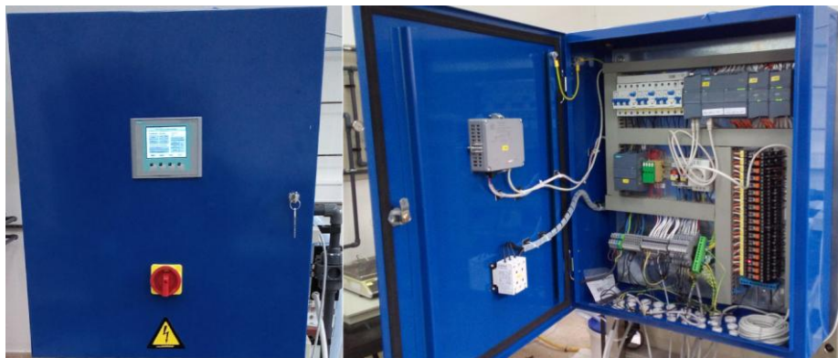
Slika 18. PLC Siemens Simatic
