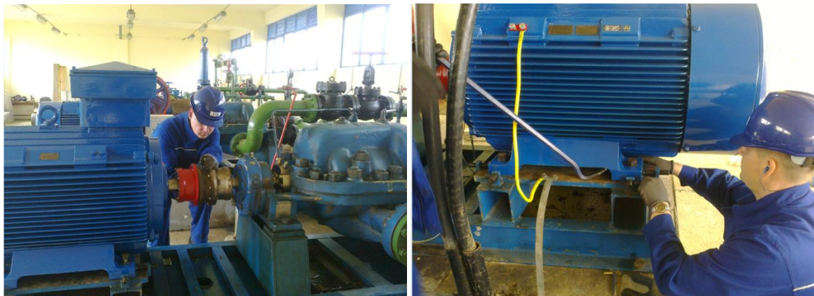
Slika 37. Montaža vijaka na spojci
