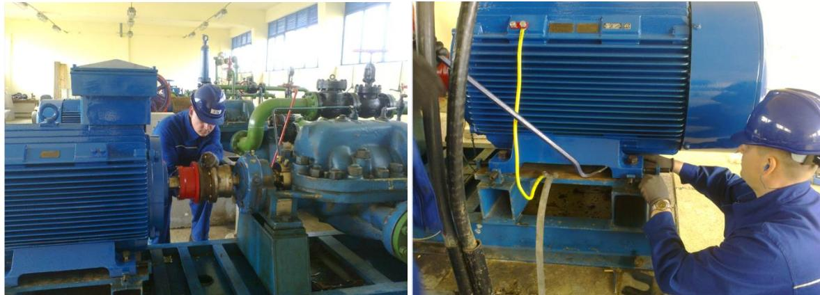
**Slika 37. Montaža vijaka na spojci**
