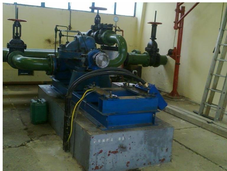
**Slika 34. Prikaz postolja i pumpe prije postavljanja elektromotora**
