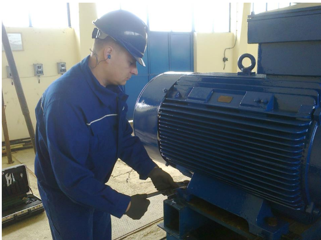
Slika 38. Stezanje temeljnih vijaka
