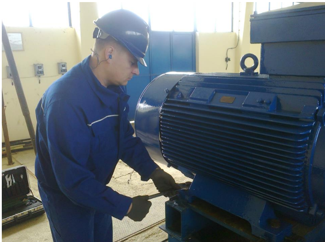
Slika 38. Stezanje temeljnih vijaka
