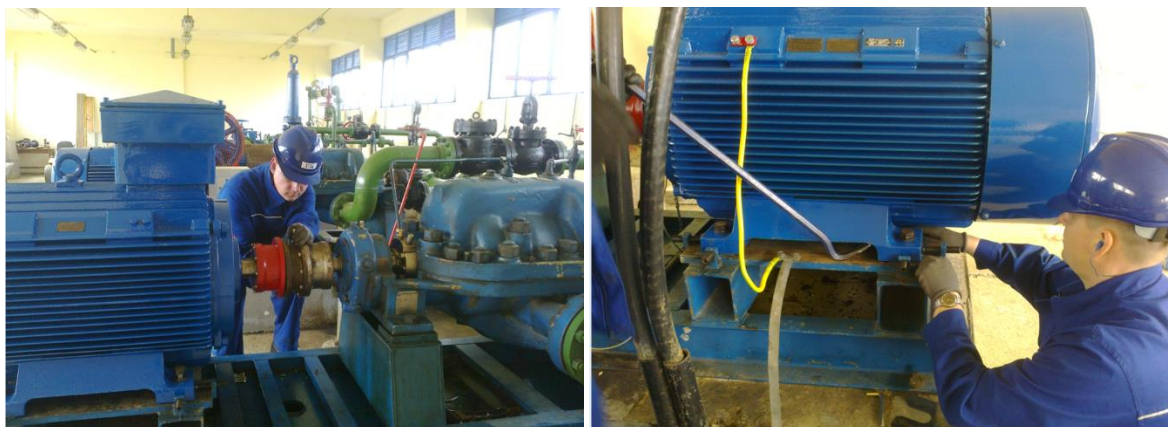
Slika 37. Montaža vijaka na spojci
