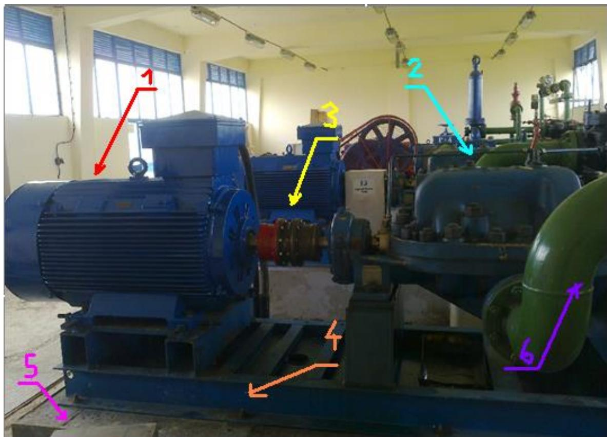
Slika 31. Set elektromotor-pumpa MP1
