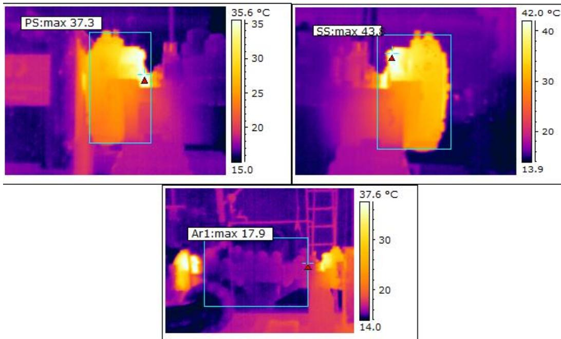
**Slika 57. Termogrami pumpe nakon centriranja**
