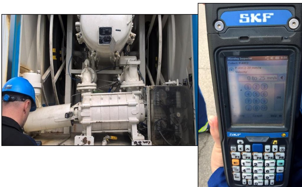
Slika 41. Mjerenje vibracija te unošenje izmjerenih vrijednosti u „Microlog Inspector“
