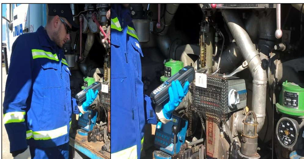
Slika 35. Provedba mjerenja/praćenja stanja na opremi
