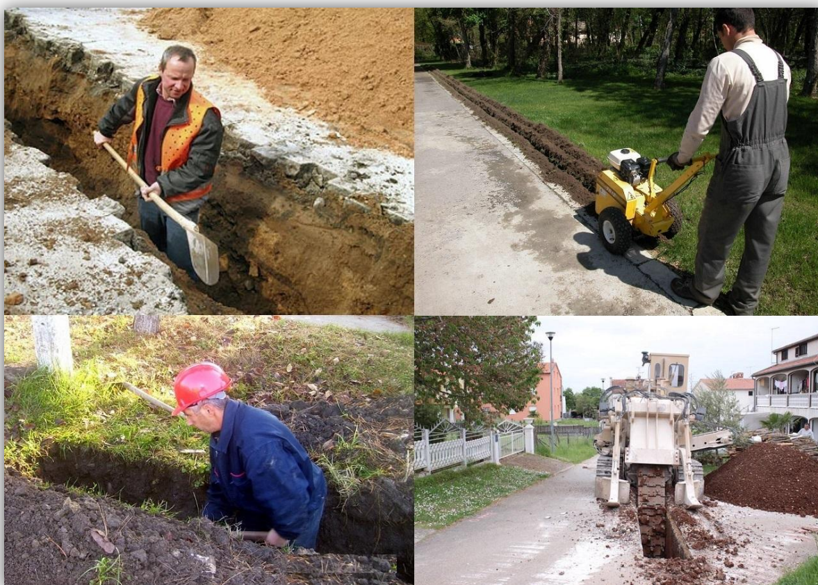
Slika 1. Primjeri pojednostavljenja radova iskopa korištenjem strojeva
