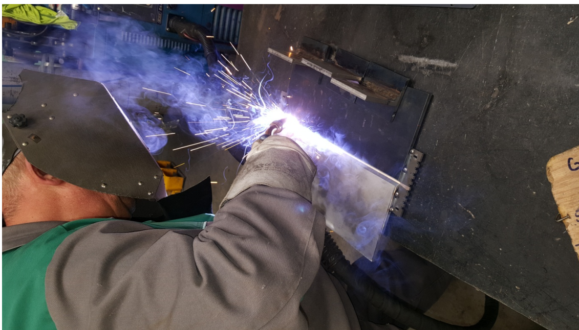
Slika 22. Zavarivanje korijena zavora sučeljenog spoja
