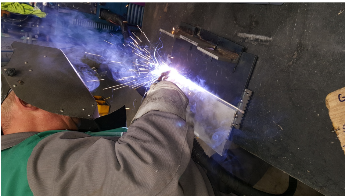
Slika 22. Zavarivanje korijena zavora sučeljenog spoja
