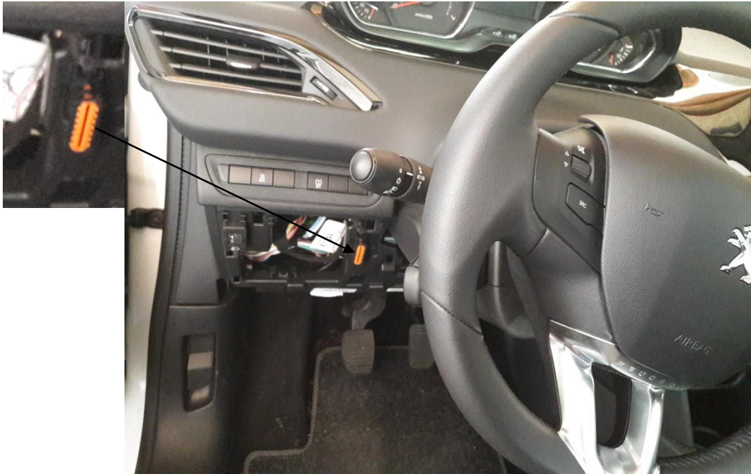
Slika 42. Dijagnostički priključak na vozilu
