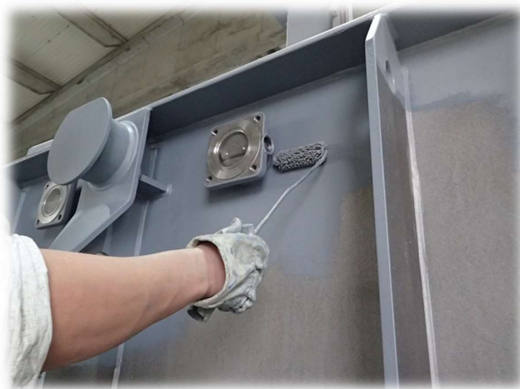
Slika 26. Nanošenje premaza valjcima na teško dostupnim mjestima [1]
