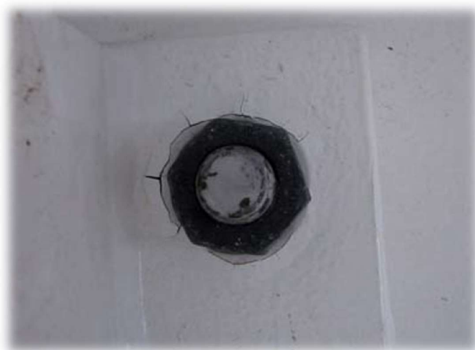
Slika 17. Pucanje premaza nakon zatezanja vijka [9]
