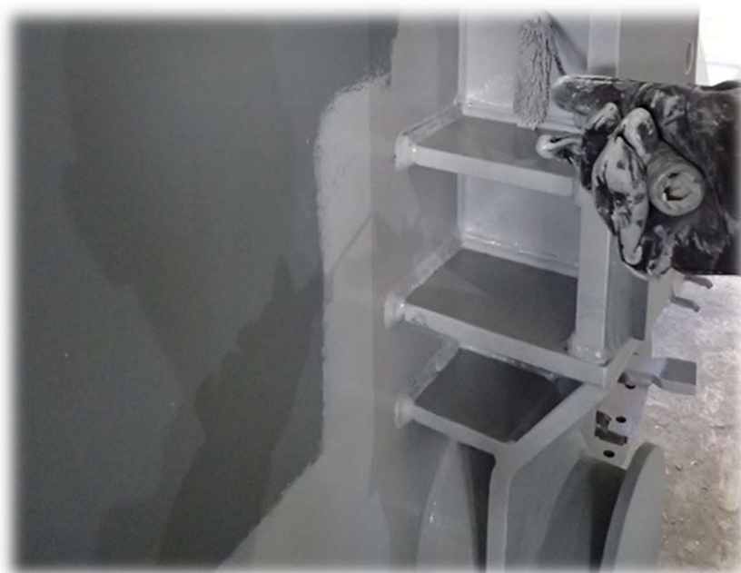
Slika 28. Epoksidni temeljni premaz i međupremaz [1]
