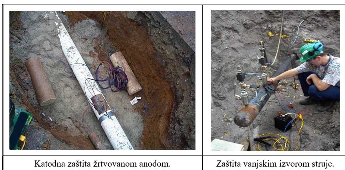
Slika 15. Načini katodne zaštite [5]
