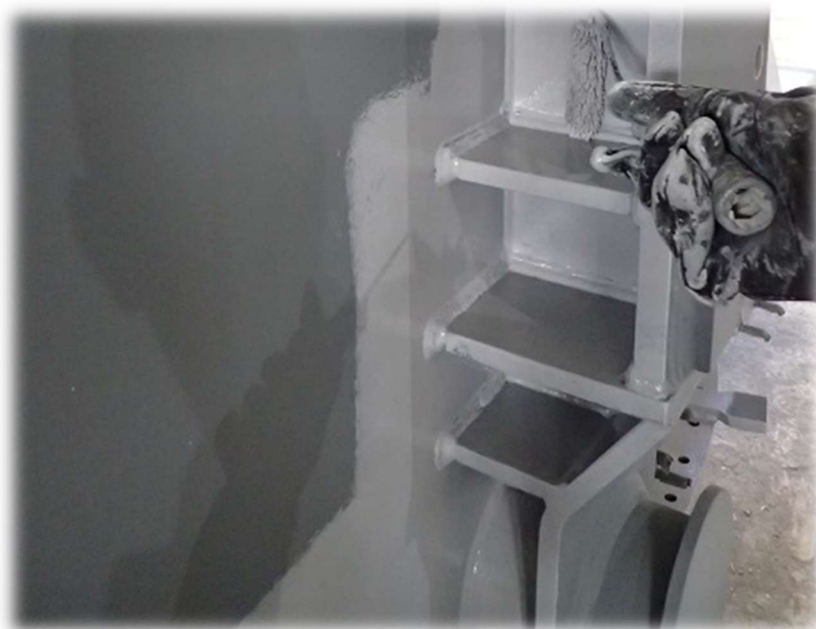
Slika 28. Epoksidni temeljni premaz i međupremaz [1]
