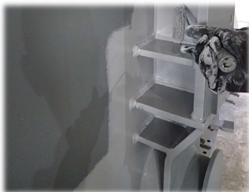
Slika 28. Epoksidni temeljni premaz i međupremaz [1]
