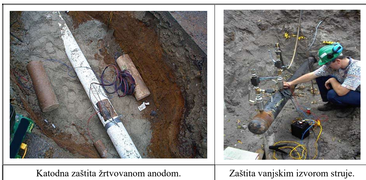
Slika 15. Načini katodne zaštite [5]
