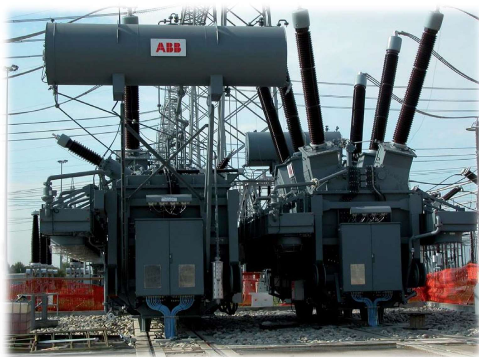
Slika 1. Prikaz energetskeg transformatora [1]
