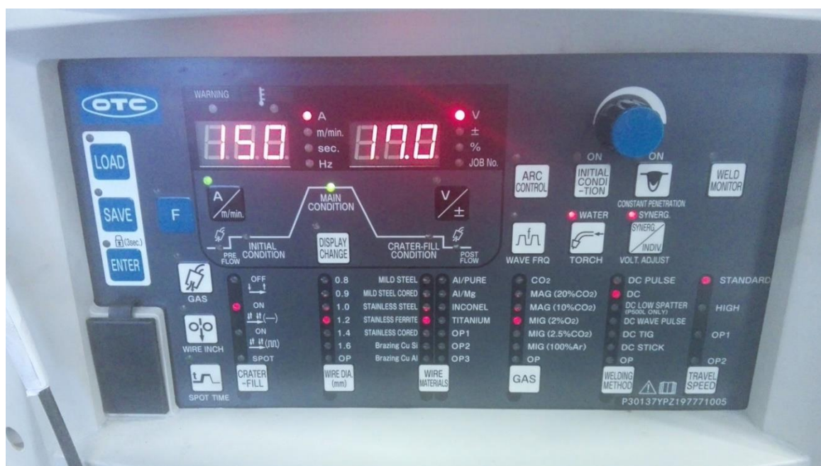
Slika 30. Parametri zavarivanja pri zavarivanju feritnog nehrđajućeg čelika
