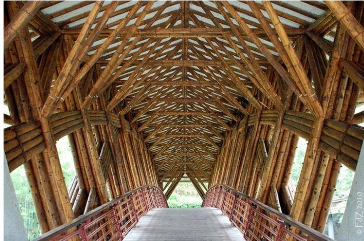
Slika 20. Primjena guadua bambusa u građevini [39]
