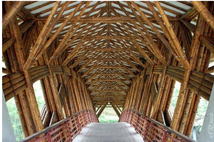
Slika 20. Primjena guadua bambusa u građevini [39]
