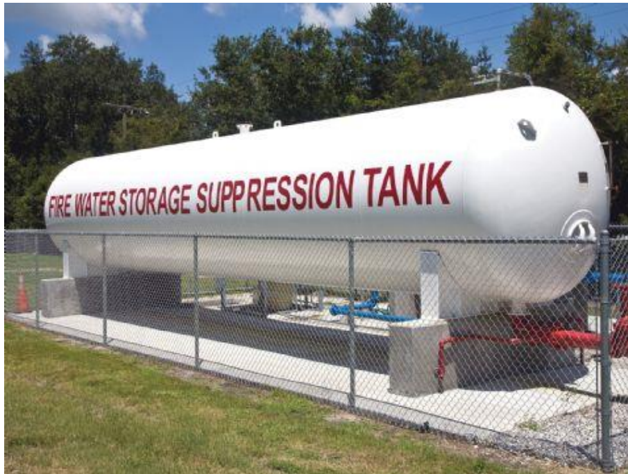
Slika 20. Prikaz sekundarnog spremnika vode za sprinkler sustav [23]
