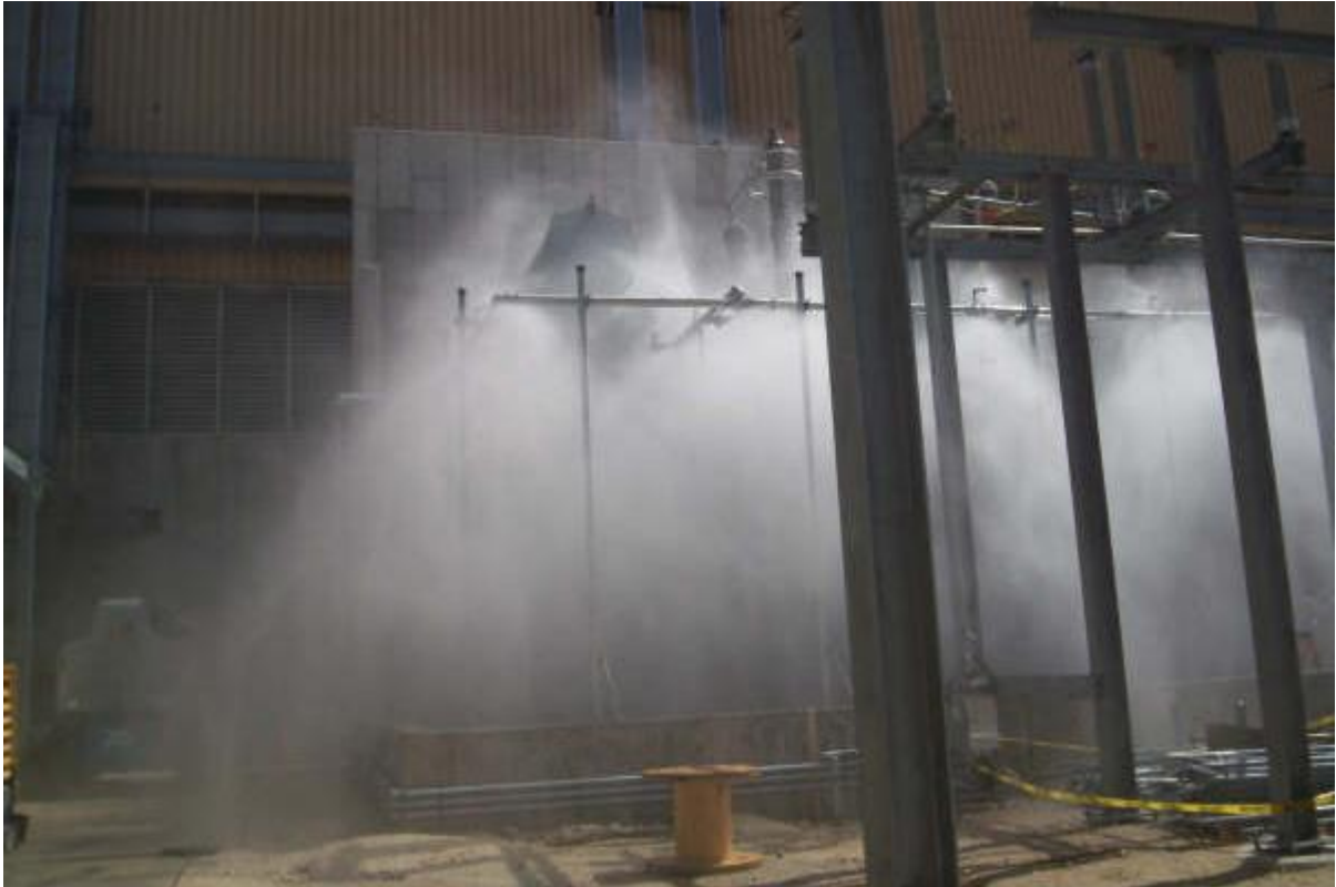
Slika 12. Prikaz aktiviranog sustava za gašenje vodenom maglom [14]
