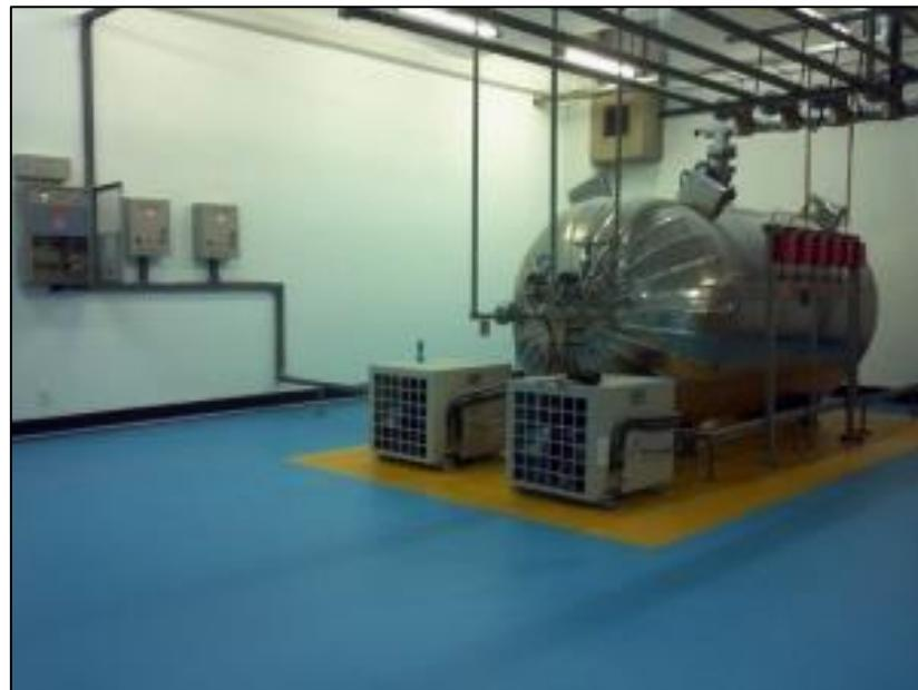
**Slika 10. Spremniči medija za gašenje niskotlačnog CO<sub>2</sub> sustava [12]**
