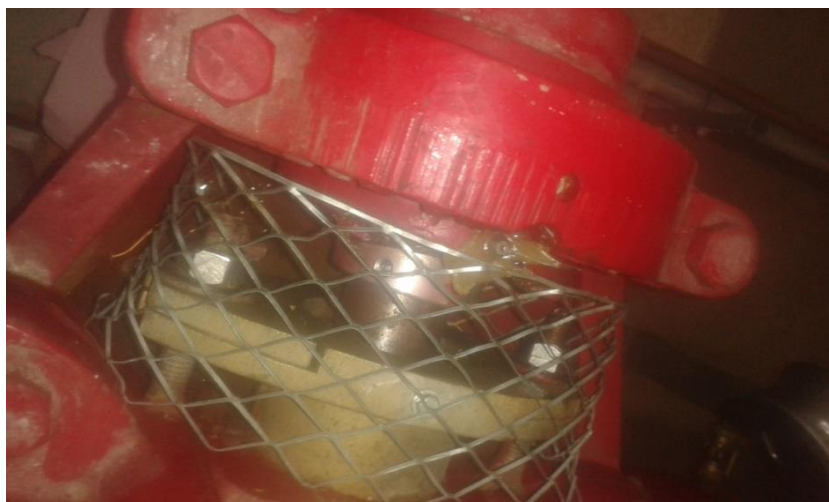
Slika 30. Podmazivanje ležaja pumpe
