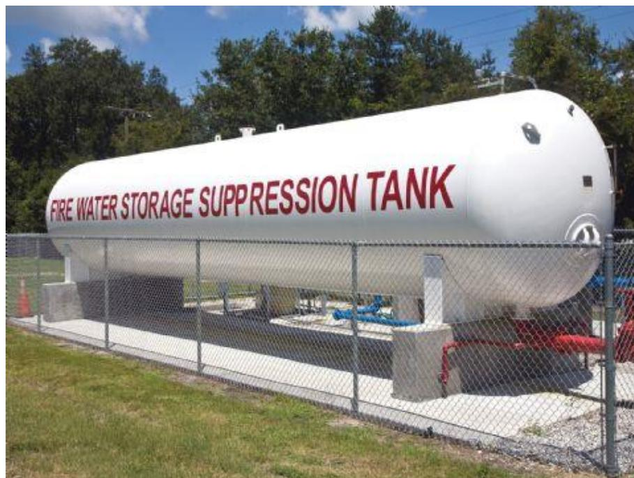
**Slika 20. Prikaz sekundarnog spremnika vode za sprinkler sustav [23]**
