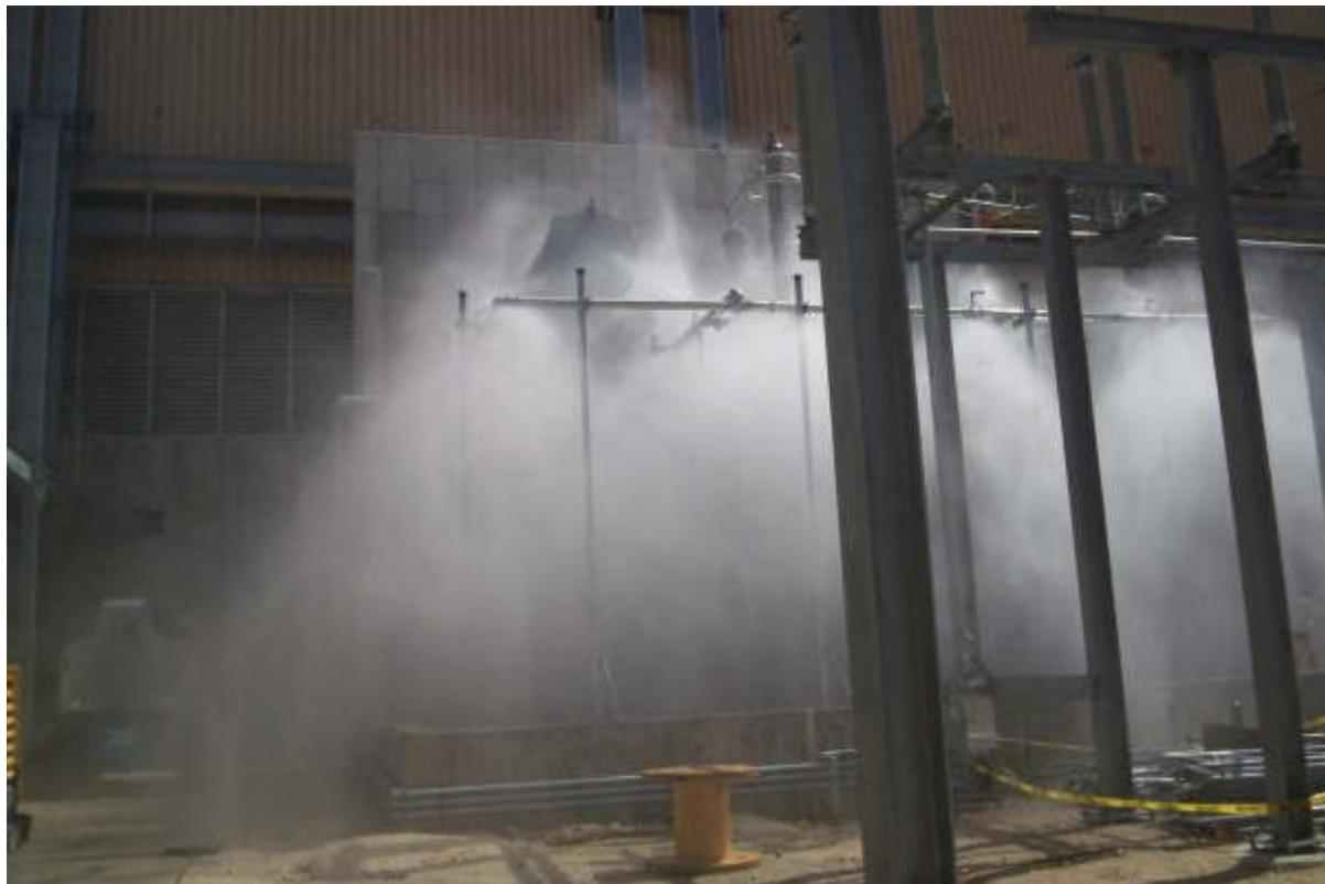
**Slika 12. Prikaz aktiviranog sustava za gašenje vodenom maglom [14]**
