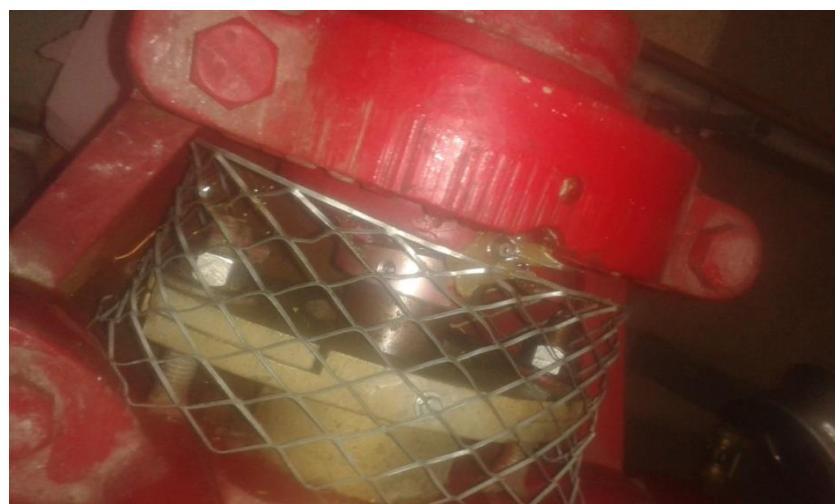
**Slika 30. Podmazivanje ležaja pumpe**
