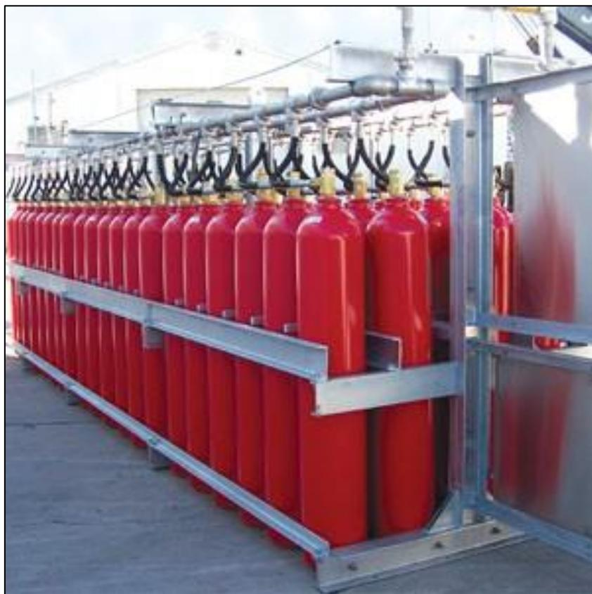
Slika 9. Spremniči medija za gašenje visokotlačnog CO<sub>2</sub> sustava [11]
