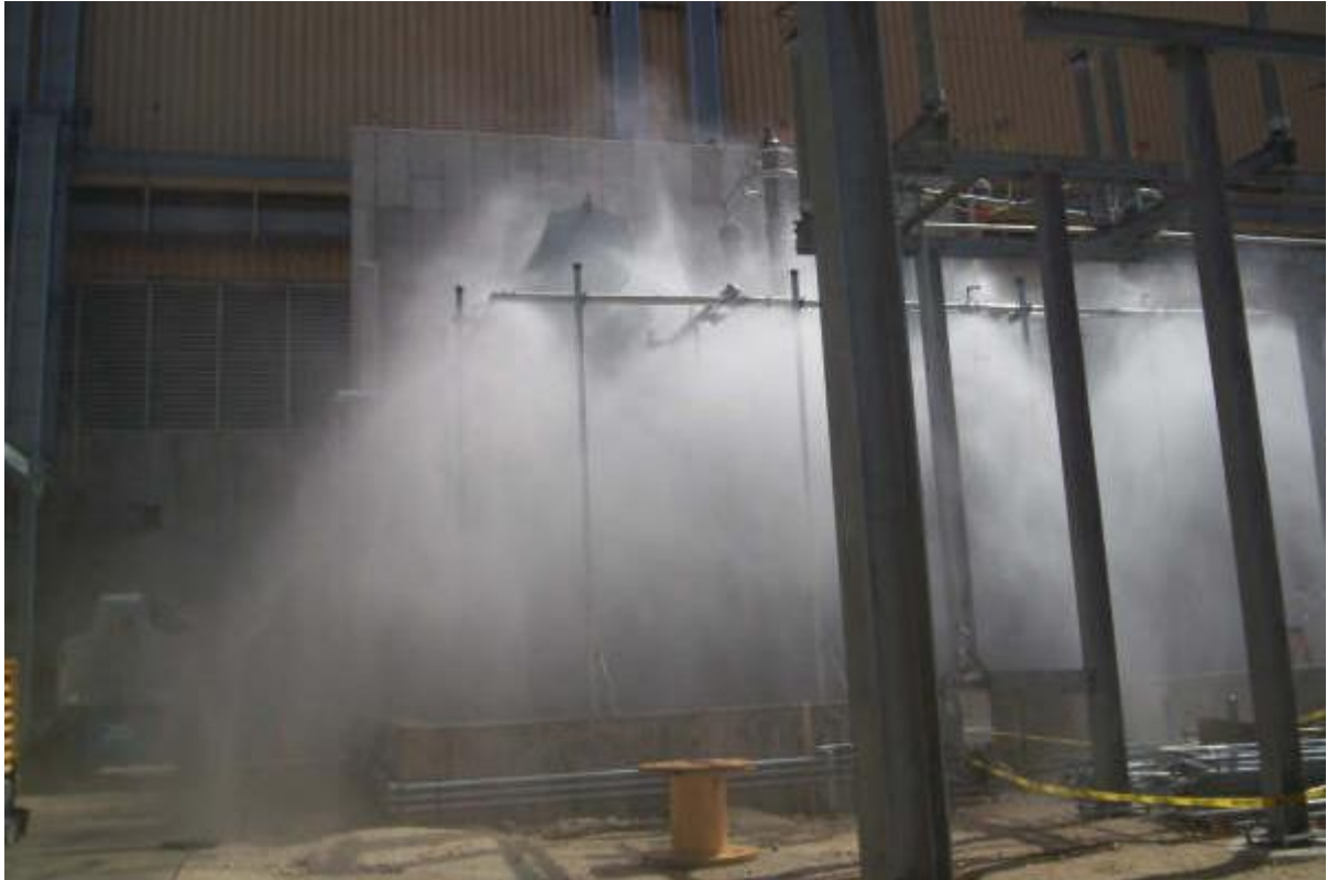
Slika 12. Prikaz aktiviranog sustava za gašenje vodenom maglom [14]
