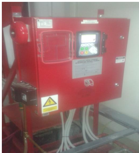
Slika 31. Upravljačka kutija pumpe
