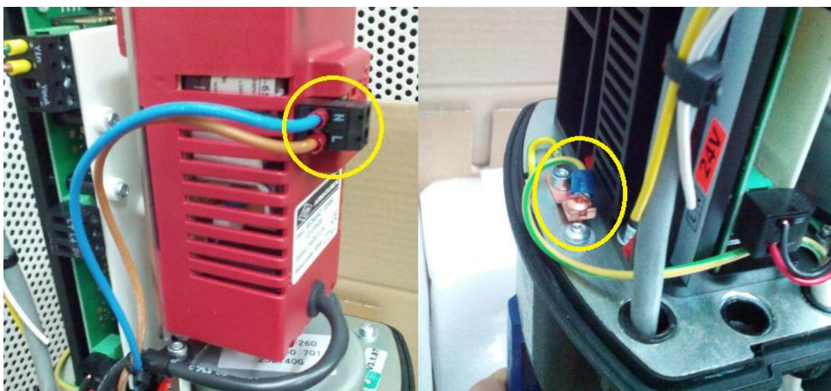
Slika 3.10. Spajanje napajanja na transformator.
