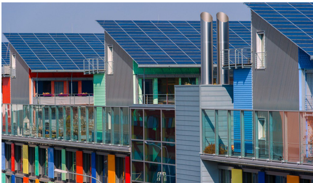
Slika 1 PV sustavi na stambenim zgradama u Freiburgu [3]
