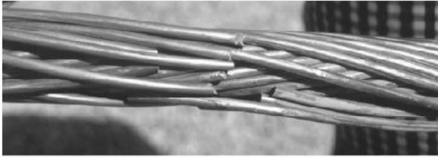
Slika 1. Oštećenje žica užeta vodiča
