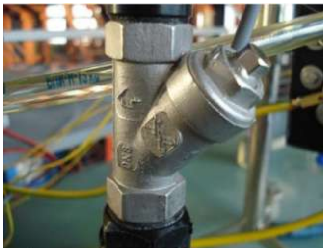
Slika 36. Hvatač nečistoća [2].
