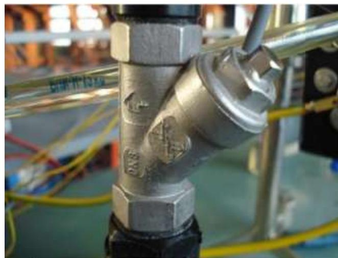
**Slika 36.** Hvatač nečistoća [2].
